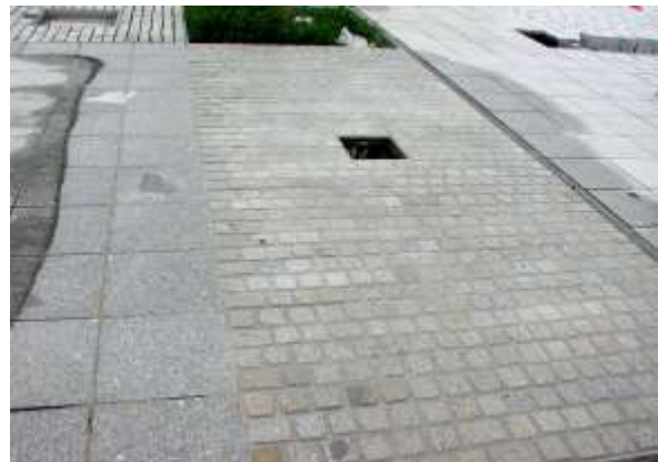
5. Fertig verfugte Fläche
