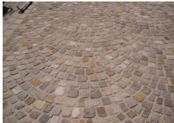
5. Fertige verfugte Fläche
