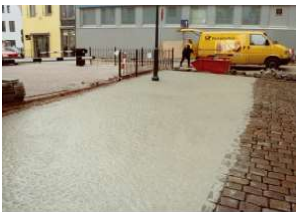
3. Fertig eingeschlänmte Fläche
