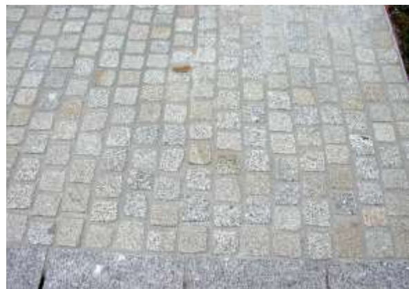
5. Fertig verfugte Fläche
