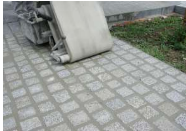
4. Reinigung mit Schwammputzmaschine
