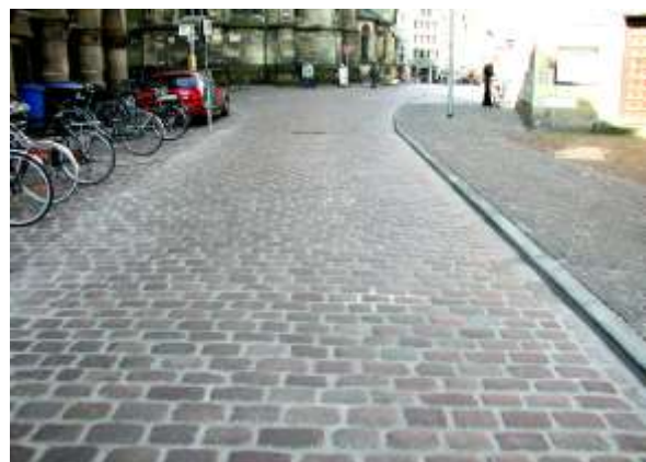
6. Fertig verfugte Fläche
