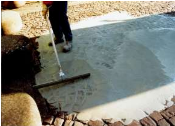
2. CEMPRO PFM einschlämmen
