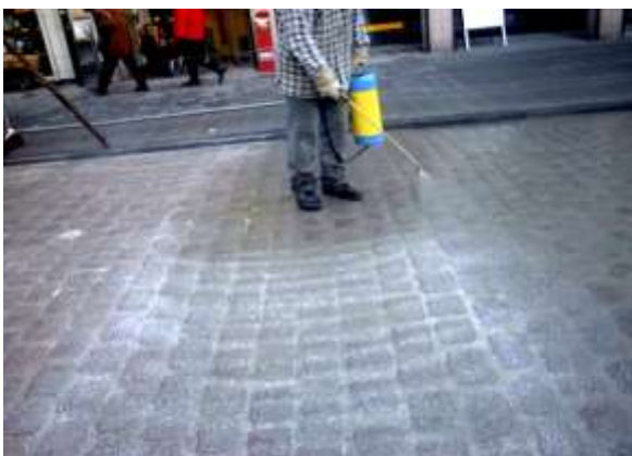
3. Fläche mit RS einsprühen
