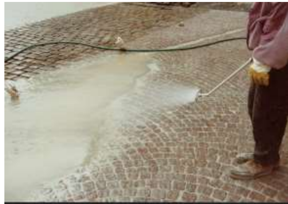
4. Reinigung mit CEMPRO Fächerdüse
