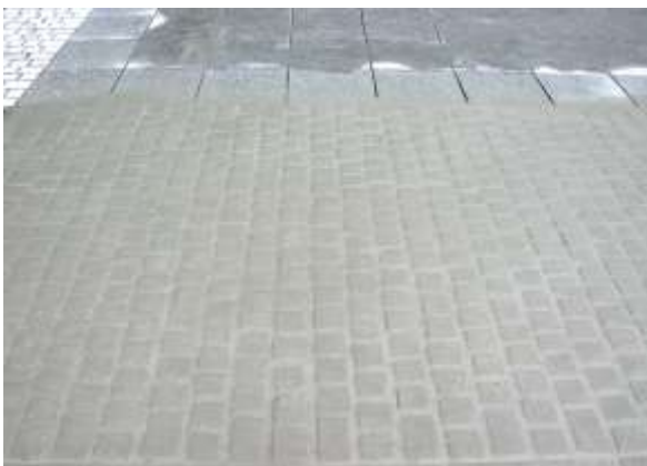
3. Fertig eingeschlämmte Fläche
