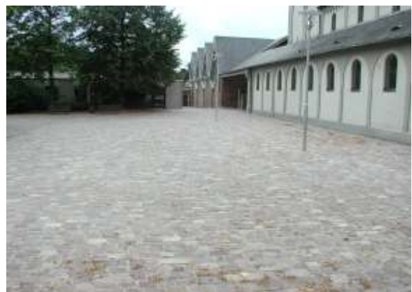
5. Fertige verfugte Fläche
