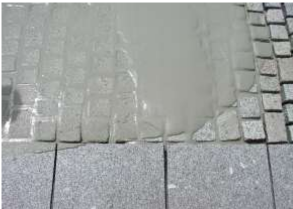
2. CEMPRO PFM einschlämmen
